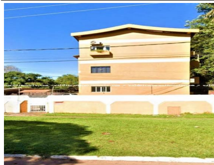
Representação Fachada Principal Descrição Data Foto 14/03/2024
