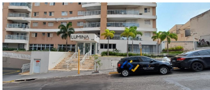
Representação Fachada Principal Descrição Data Foto 20/09/2024
