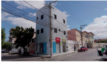
Representação Fachada Principal Descrição
