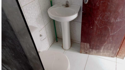
Representação Banheiro Descrição 3
