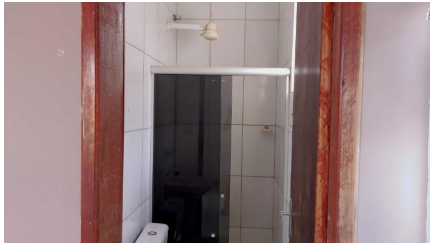
Representação Banheiro Descrição 2
