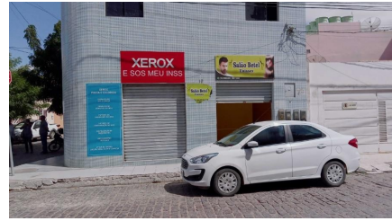
Representação Fachada Principal Descrição
