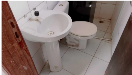
Representação Banheiro Descrição 2
