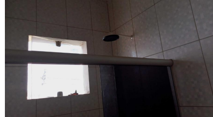
Representação Banheiro Descrição 3
