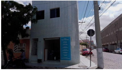
Representação Fachada Principal Descrição
