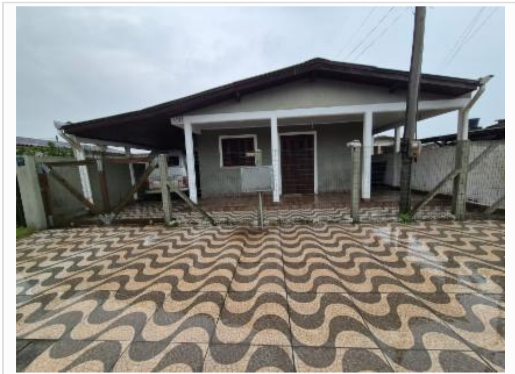
Fachada do avaliando - vista 01
