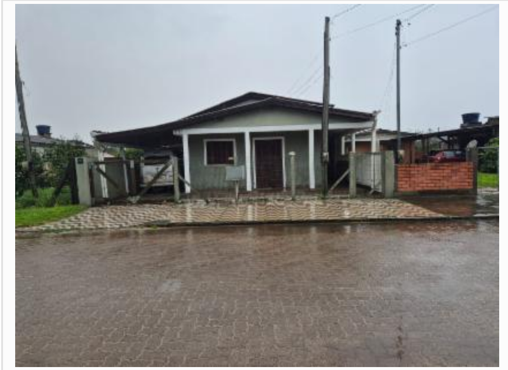
Fachada do avaliando - vista 03
