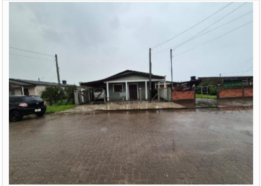
Fachada do avaliando - vista 02
