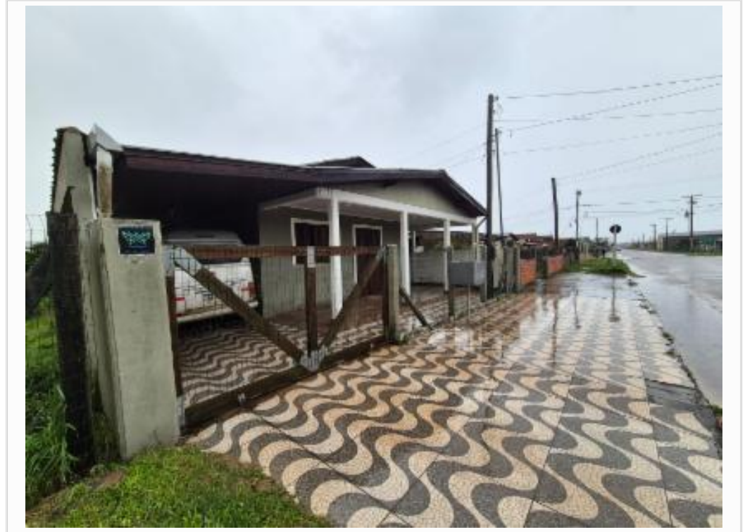
Fachada do avaliando - vista 04
