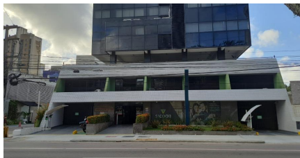
Representação Fachada Principal Descrição Data Foto 27/12/2023
