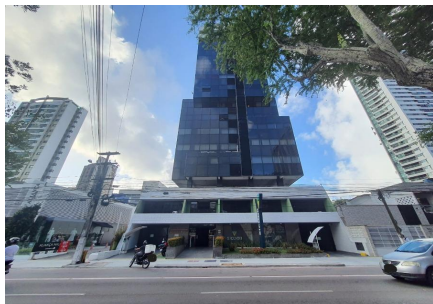
Representação Fachada Principal Descrição Data Foto 27/12/2023
