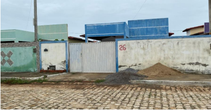
Representação Vista da Rua Descrição Imóvel vizinho Data Foto 27/03/2024
