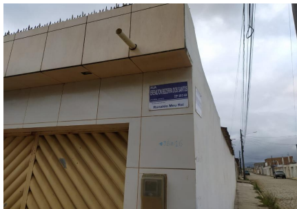
Representação Identificação Numérica Descrição PLACA DA RUA Data Foto 08/09/2023
