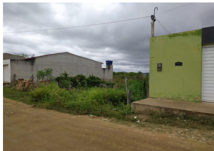
Representação Vista da Rua Descrição VIZINHO DA ESQUERDA Data Foto 08/09/2023
