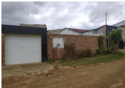
Representação Vista da Rua Descrição VIZINHO DA DIREITA Data Foto 08/09/2023
