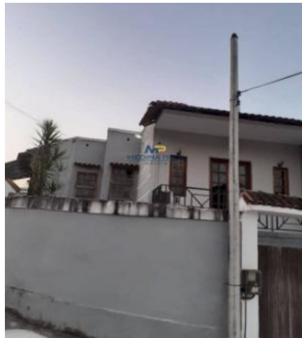
Representação Fachada Principal Descrição Data Foto 07/02/2024
