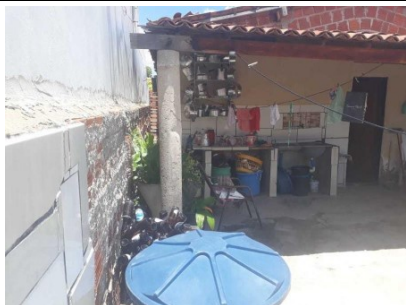
Representação Área de Serviço Coberta Descrição Data Foto 11/11/2021
