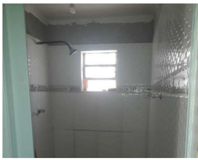
Representação Banheiro social Descrição Data Foto 11/11/2021
