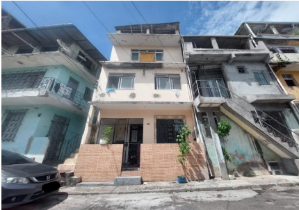
Representação Fachada Principal Descrição Data Foto 27/03/2024
