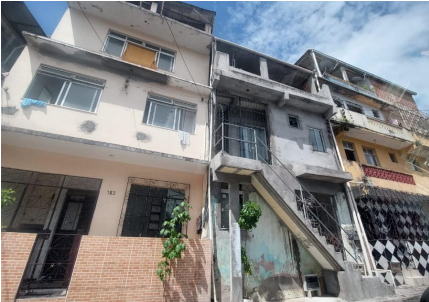
Representação Fachada Principal Descrição Data Foto 27/03/2024
