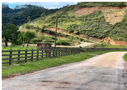
Representação Fachada Principal Descrição Data Foto 18/10/2023
