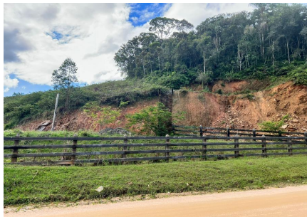
Representação Fachada Principal Descrição Data Foto 18/10/2023
