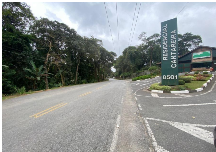
Representação Vista da Rua Descrição CONDOMÍNIO Data Foto 19/07/2023
