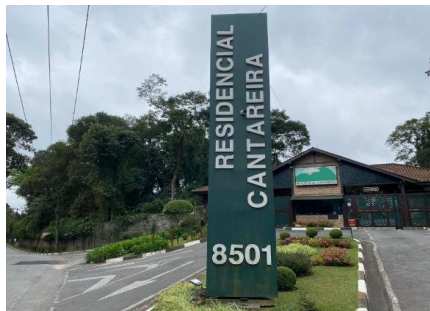
Representação Identificação Numérica Descrição CONDOMÍNIO Data Foto 24/07/2023
