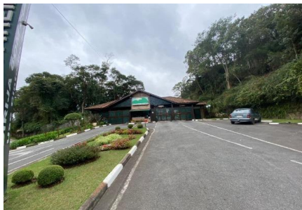
Representação Fachada Principal Descrição CONDOMÍNIO Data Foto 24/07/2023
