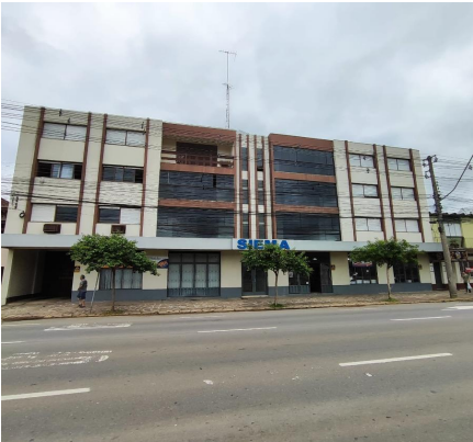
Representação Fachada Principal Descrição Data Foto 04/01/2024
