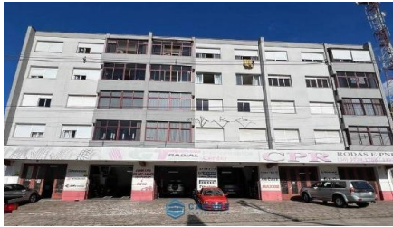
Representação Fachada Principal Descrição Data Foto 05/01/2024
