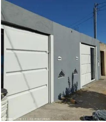
Representação Fachada Principal Descrição AMOSTRA 3 Data Foto 25/09/2023
