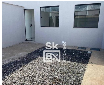
Representação Fachada Principal Descrição AMOSTRA 1 Data Foto 25/09/2023
