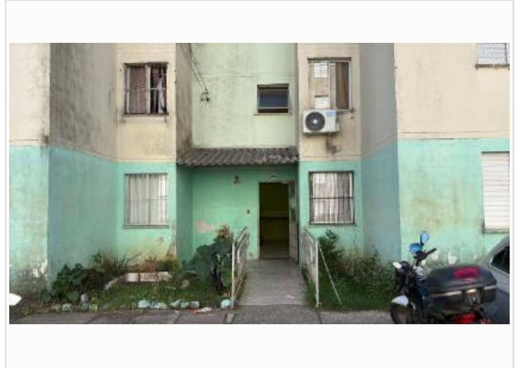
acesso ao bloco 04
