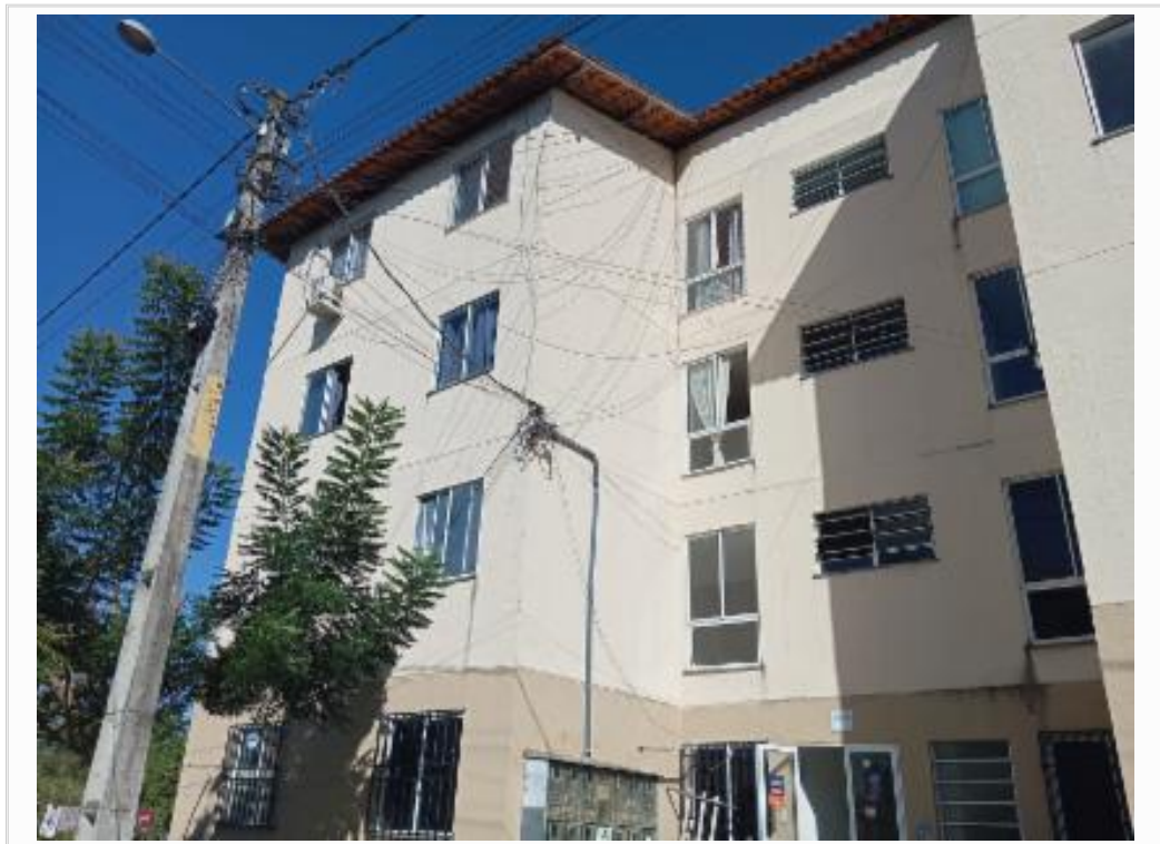
Fachada do bloco
