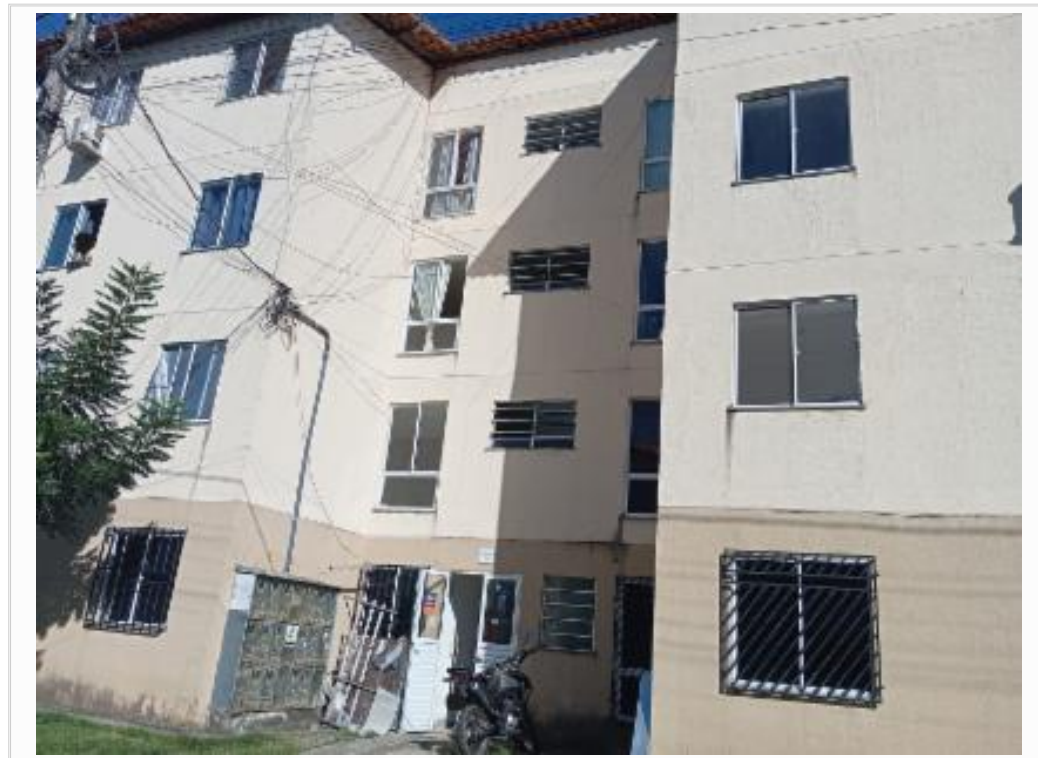
Fachada do bloco
