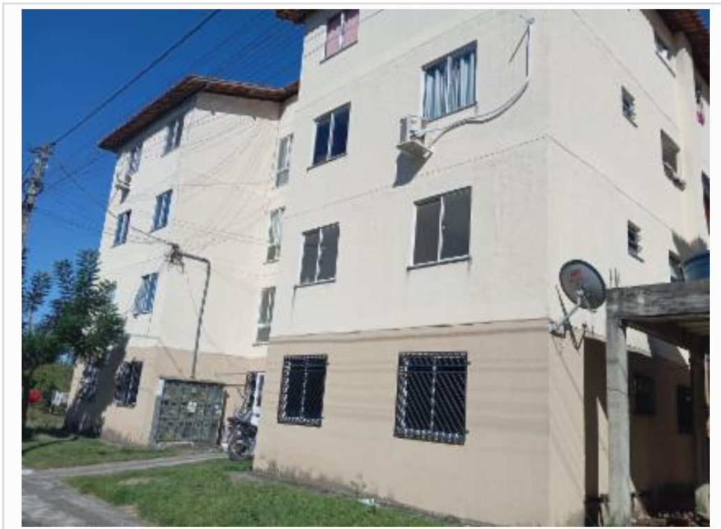
Fachada do bloco
