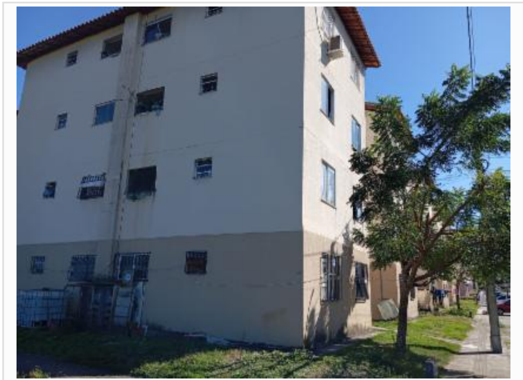
Fachada do bloco
