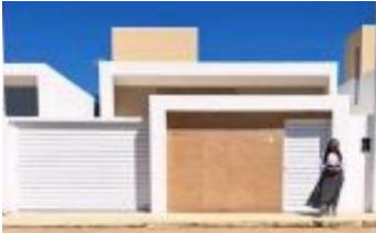
Representação Fachada Principal Descrição Data Foto 16/10/2025
