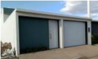
Representação Fachada Principal Descrição Data Foto 16/10/2025
