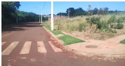
Representação Vista da Rua Descrição Data Foto 22/05/2024
