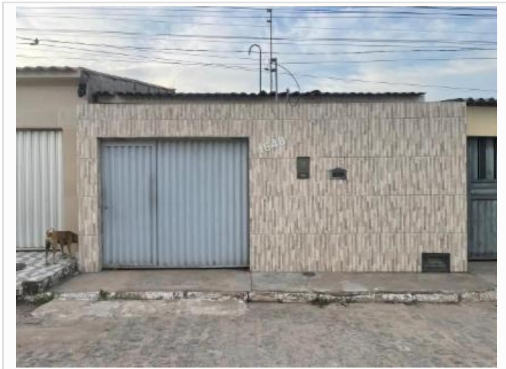
Fachada do avaliando
