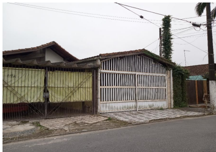
Representação Fachada Principal Descrição Data Foto 25/09/2024
