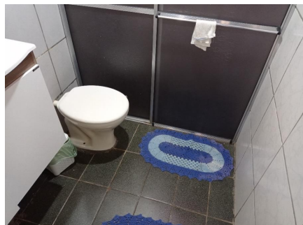
Representação Banheiro social Descrição Data Foto 27/06/2022
