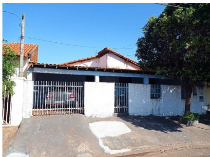
Representação Vista da Rua Descrição Vizinho direito Data Foto 27/06/2022
