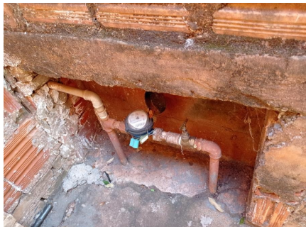
Representação Fachada Principal Descrição Cavalete de água Data Foto 27/06/2022
