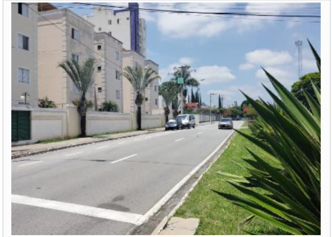
vista parcial da fachada
