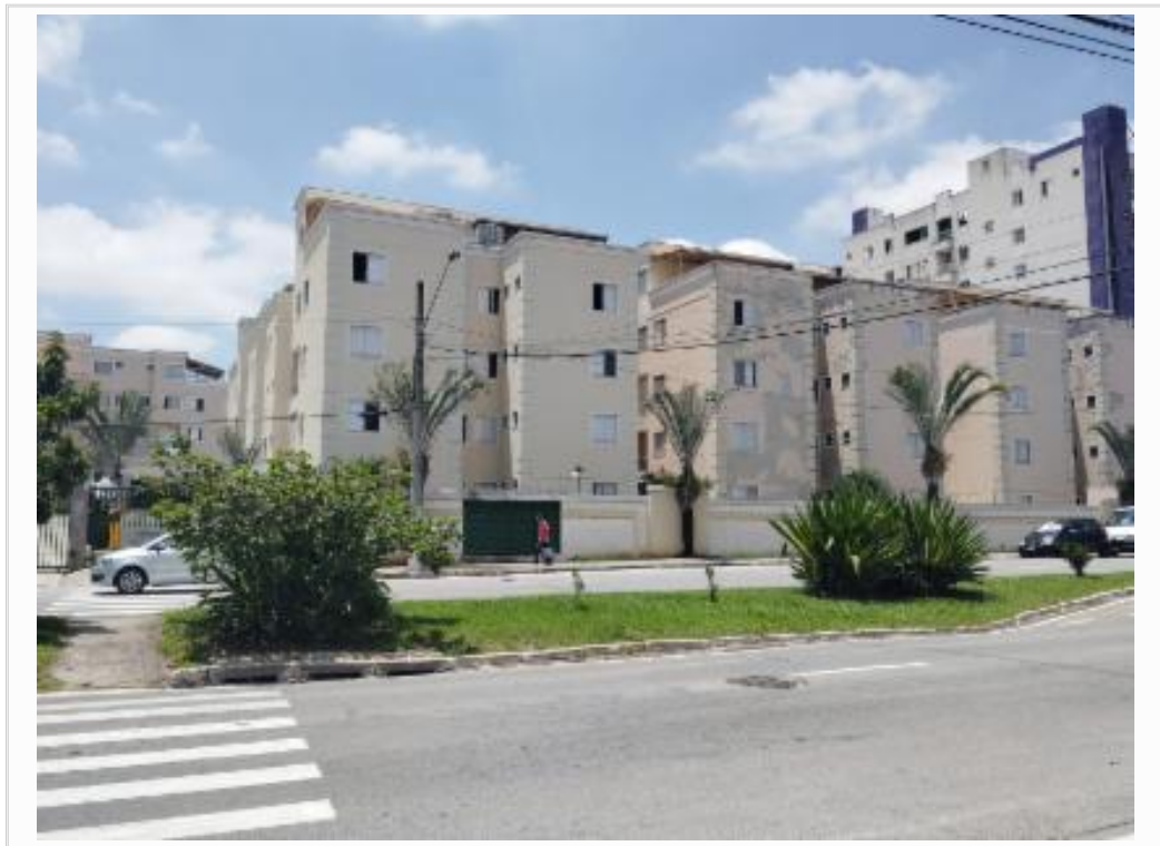
vista parcial da fachada
