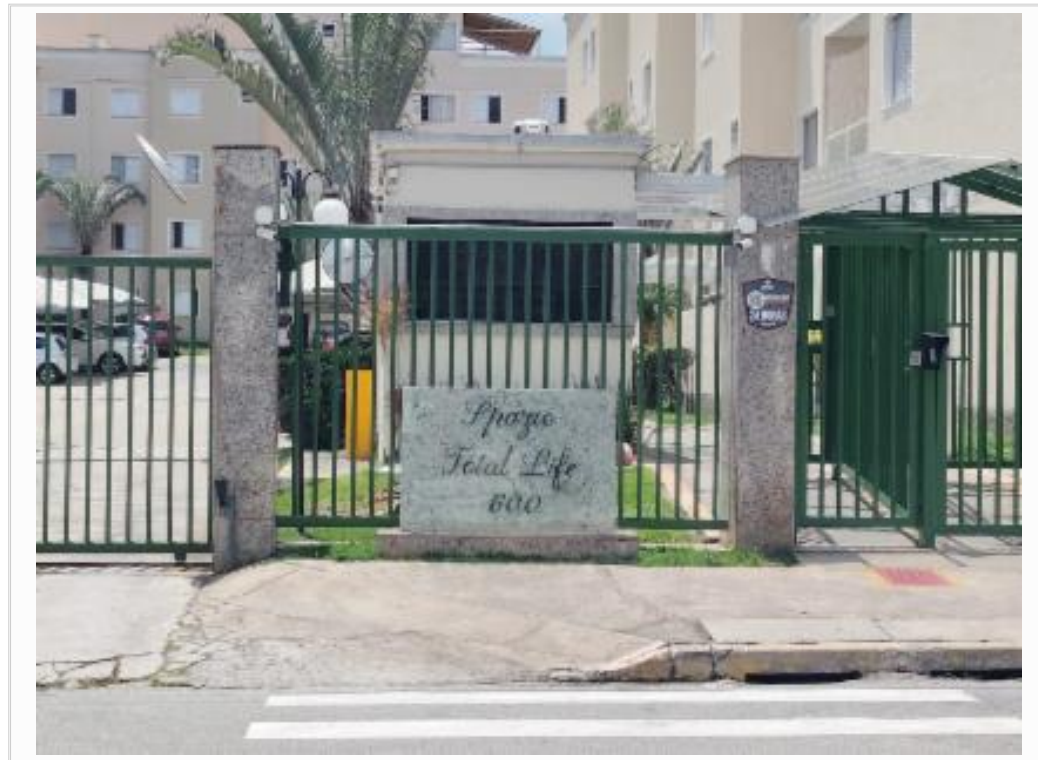
vista parcial da fachada
