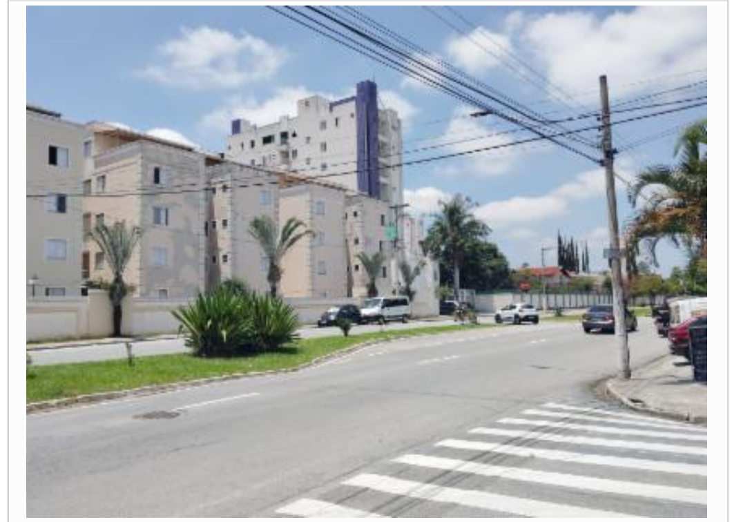
vista parcial da fachada
