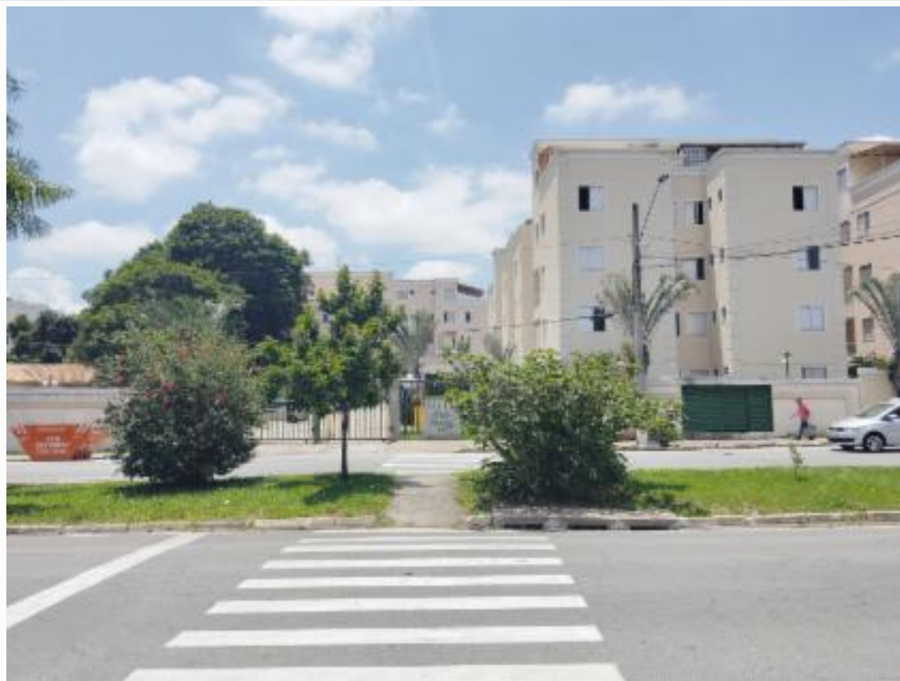
vista parcial da fachada
