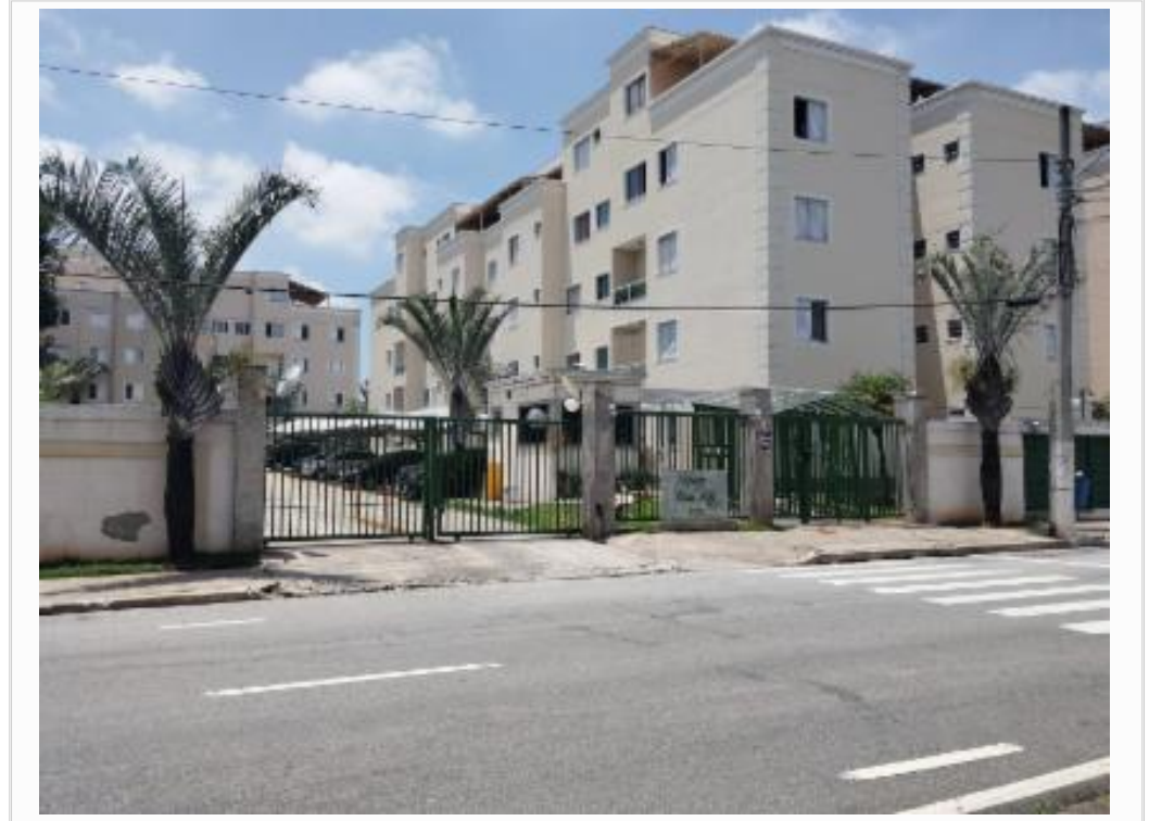
vista parcial da fachada
