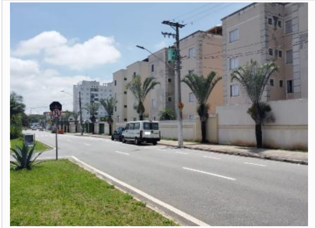
vista parcial da fachada
