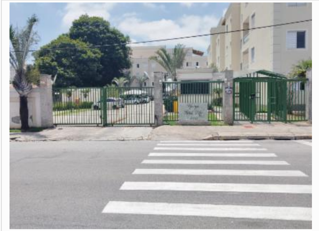
vista parcial da fachada
