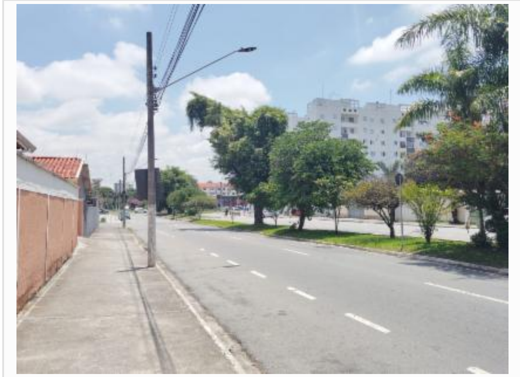
vista parcial da fachada
