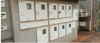
Representação Fachada Principal Descrição RELOGIO Data Foto 26/05/2025
