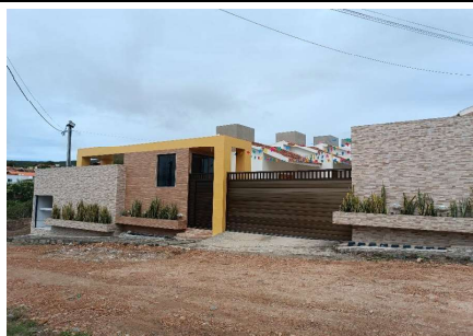
Representação Fachada Principal Descrição Data Foto 19/06/2024
