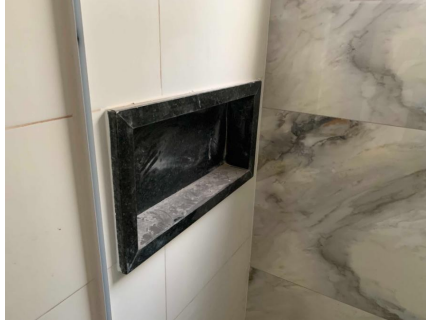
Representação Banheiro social Descrição Data Foto 02/06/2021
