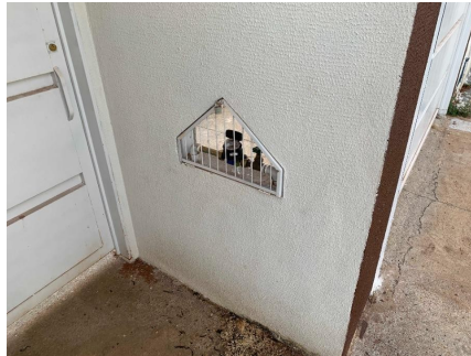
Representação Descrição MEDIDORES Data Foto 02/06/2021
