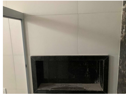
Representação Banheiro Suíte Descrição Data Foto 02/06/2021
