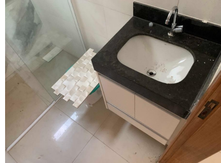
Representação Banheiro social Descrição Data Foto 02/06/2021
