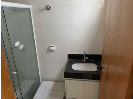
Representação Banheiro Suíte Descrição Data Foto 02/06/2021
