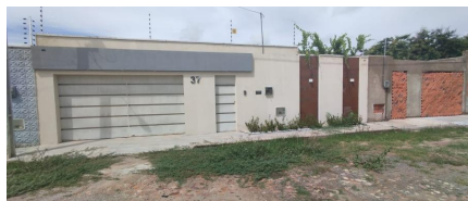
Representação Escritório Descrição Fachada do Avaliando Data Foto 20/02/2024
