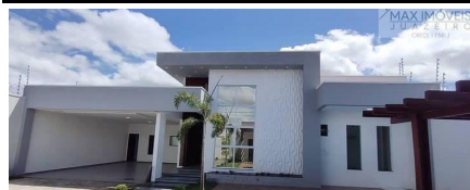
Representação Fachada Principal Descrição Data Foto 21/02/2024
