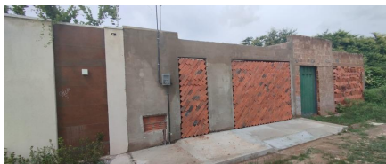
Representação Vista da Rua Descrição Vizinho Direito Data Foto 20/02/2024
