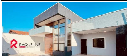
Representação Fachada Principal Descrição Data Foto 21/02/2024
