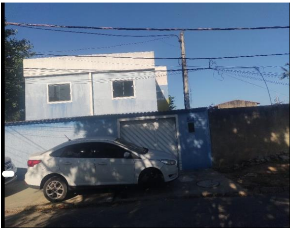
Fachada do avaliando
