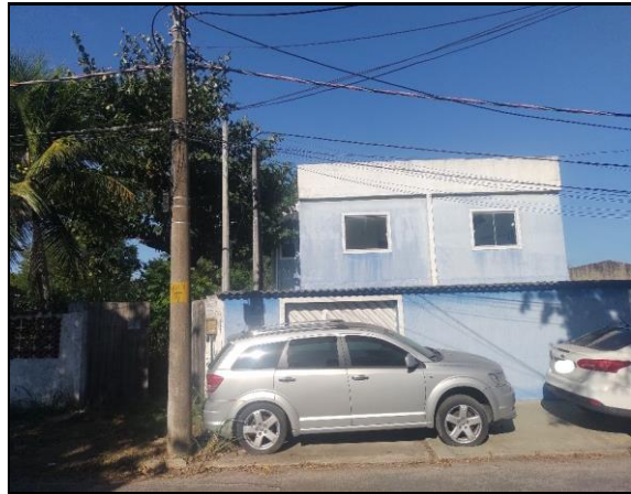
Fachada do avaliando
