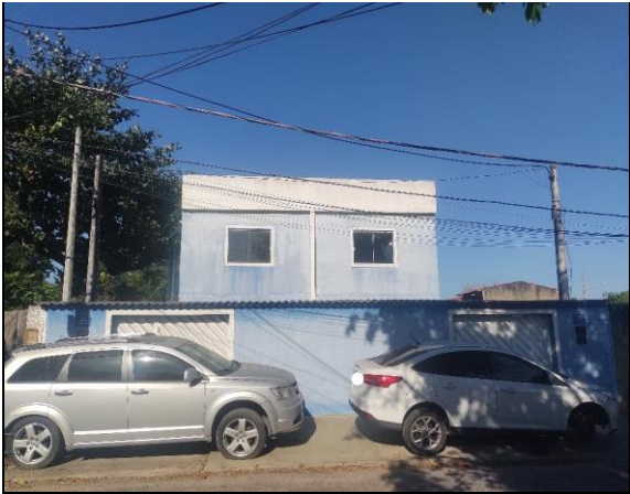
Fachada do avaliando
