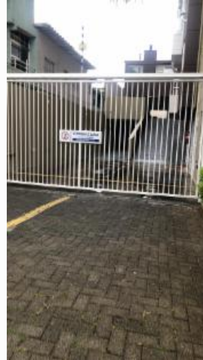
Acesso de veículos
