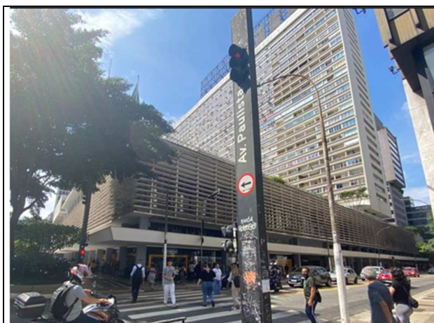
Vista parcial do Conjunto Nacional, onde se encontra o empreendimento que se situa o imóvel em estudo.
