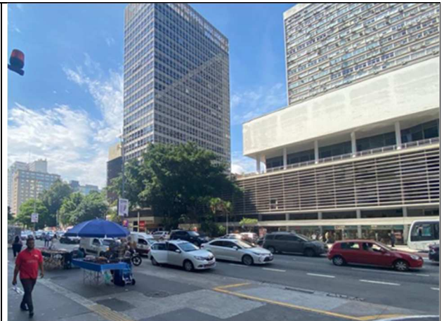
Outra vista parcial da Av. Paulista, onde se encontra o empreendimento que se situa o imóvel em estudo.
