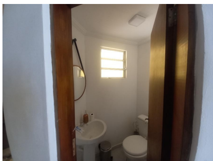
Representação Lavabo (não deve ser considerado na soma total dos banheiros) Descrição Data Foto 06/06/2022
