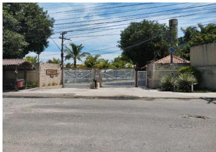
Representação Fachada Principal Descrição Data Foto 29/02/2024
