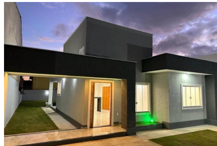
Representação Fachada Principal Descrição Data Foto 01/03/2024
