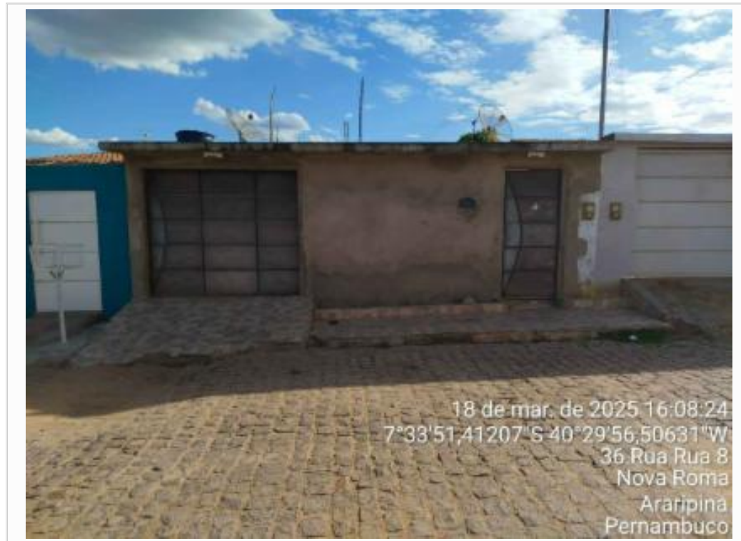
Fachada com Coordenada
