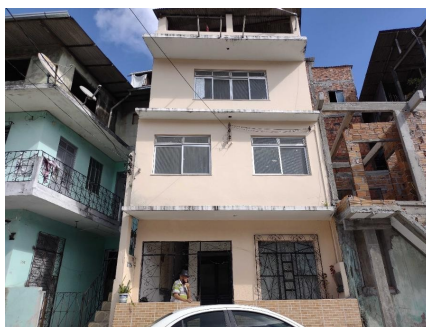
Representação Fachada Principal Descrição Data Foto 13/08/2021
