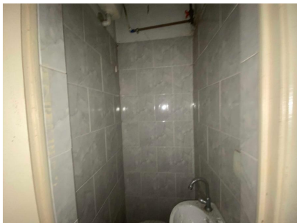
Representação Banheiro Descrição Data Foto 24/05/2021
