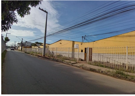
Representação Vista da Rua Descrição Data Foto 16/05/2023
