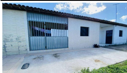
Representação Fachada Principal Descrição Data Foto 17/05/2023
