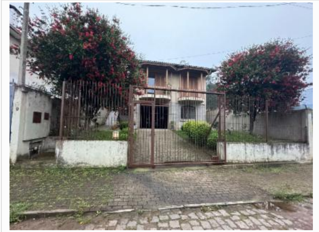
Vista da fachada
