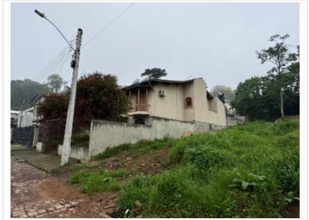
Vista da fachada lateral
