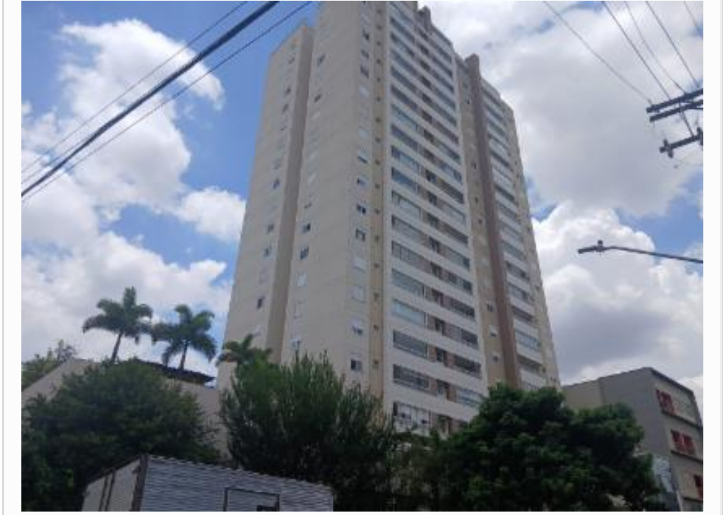
Vista lateral / fachada
