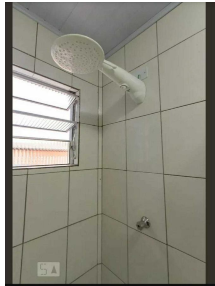
Representação Banheiro social Descrição Data Foto 09/12/2021
