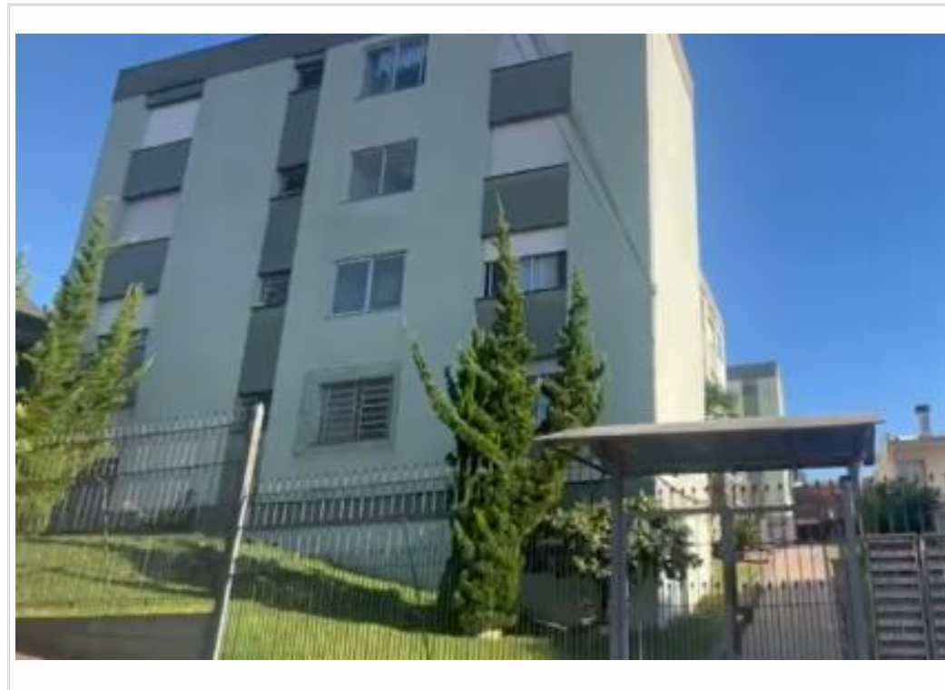
vista parcial da fachada do edifício
