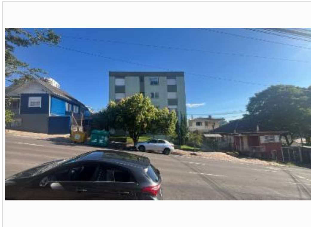
vista parcial da fachada do edifício
