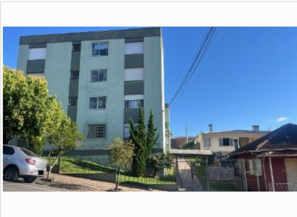
vista parcial da fachada do edifício
