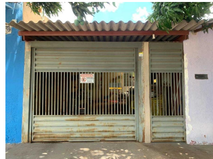
Representação Fachada Principal Descrição Data Foto 29/11/2021
