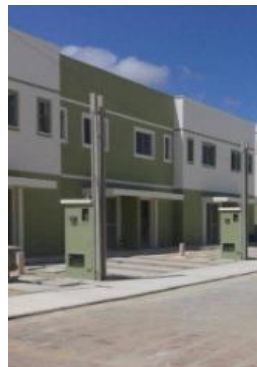
Representação Fachada Principal Descrição Data Foto 17/01/2024
