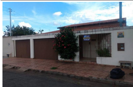
Representação Fachada Principal Descrição Data Foto 29/03/2023
