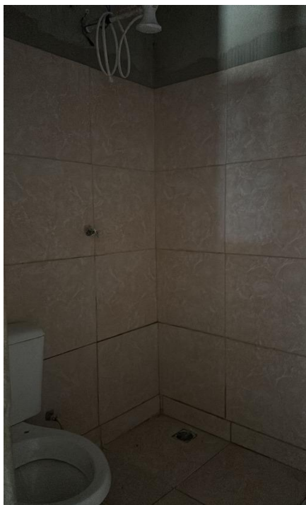
Representação Banheiro social Descrição Data Foto 30/03/2023
