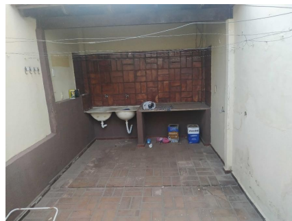
Representação Área de Serviço Coberta Descrição Data Foto 20/08/2021
