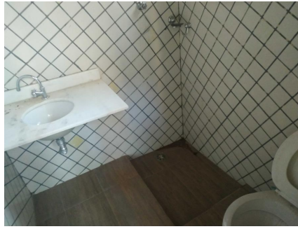
Representação Banheiro social Descrição 1 Data Foto 20/08/2021
