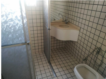
Representação Banheiro social Descrição 2 Data Foto 20/08/2021
