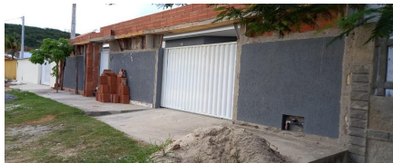
Representação Fachada Principal Descrição Data Foto 07/03/2023
