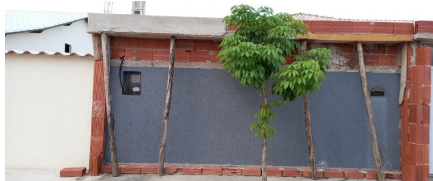
Representação Fachada Principal Descrição Data Foto 07/03/2023
