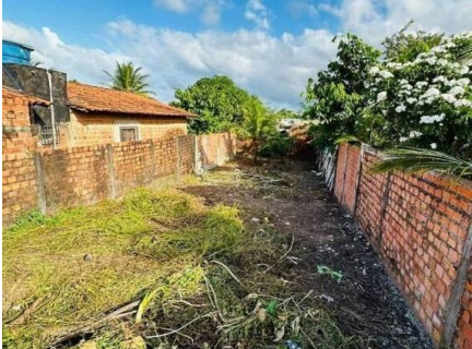
Representação Fachada Principal Descrição AMOSTRA 5 Data Foto 12/12/2023
