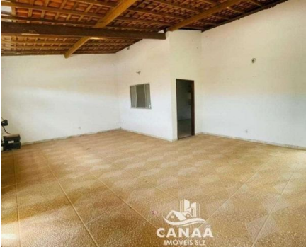
Representação Fachada Principal Descrição AMOSTRA 4 Data Foto 12/12/2023
