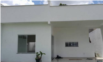
Representação Fachada Principal Descrição AMOSTRA 2 Data Foto 12/12/2023
