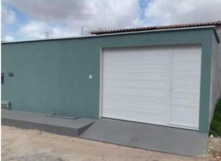
Representação Fachada Principal Descrição AMOSTRA 3 Data Foto 12/12/2023
