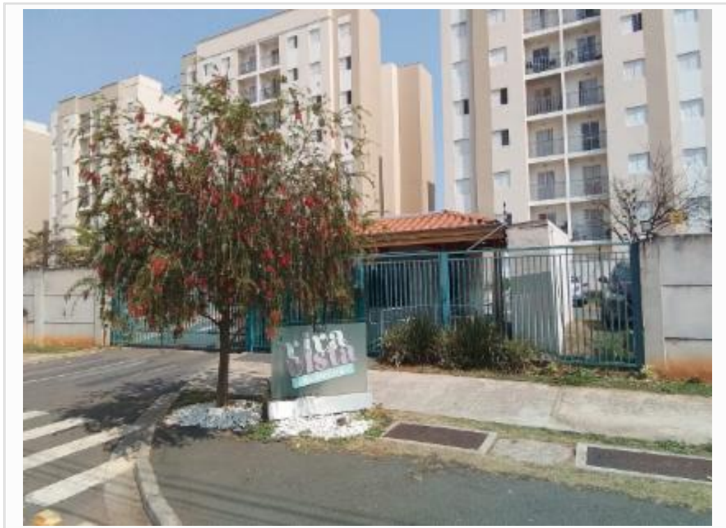
Identificação / Fachada do condomínio, vista 01
