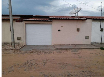
Representação Fachada Principal Descrição Data Foto 13/01/2022
