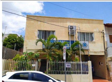
Representação Fachada Principal Descrição Data Foto 27/03/2023
