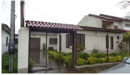
Representação Fachada Descrição Data da Foto 09/10/2015
