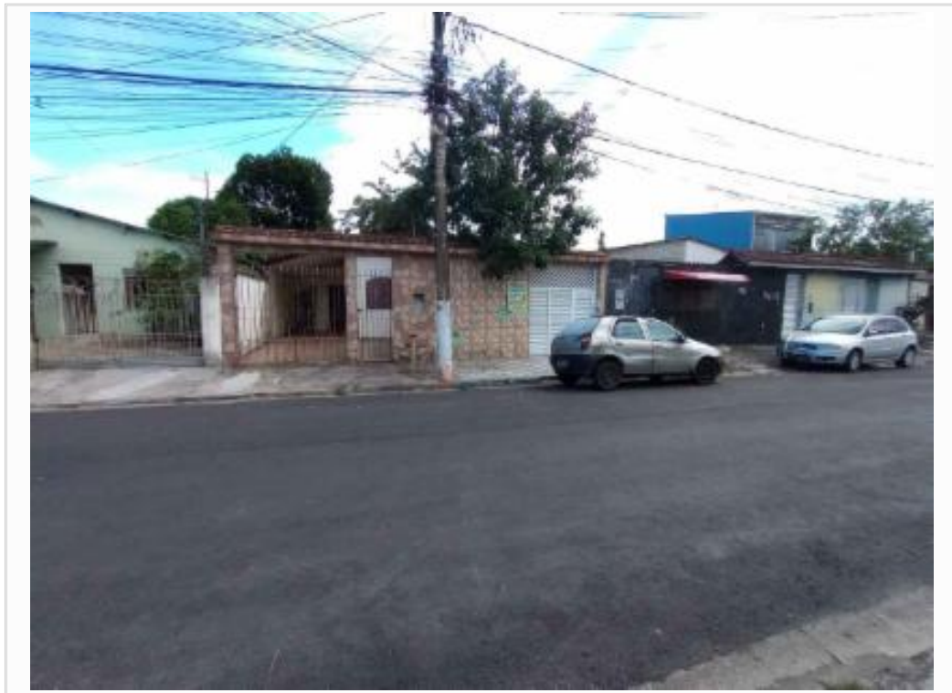
vista da fachada vizinhos
